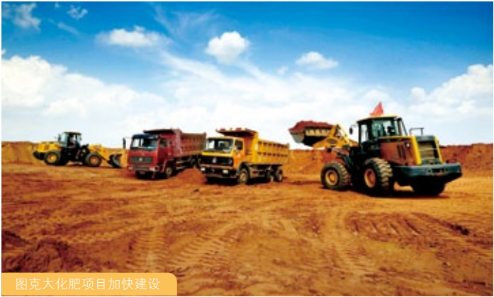
图克大化肥项目加快建设
