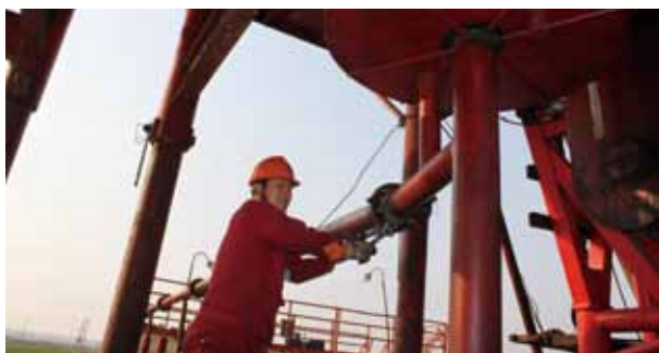
井下大修作业中修井液回收不及时就会污染井场，这一直是个环保难题。中国石化河南油田自主设计、制作成密闭循环装置，使修井液通过回收管线流入泥浆罐，进行集中处理，实现了清洁生产。图为一名职工正在连接回收管线
