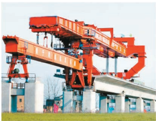
交通银行支持京沪高铁常州西特大桥梁施工
