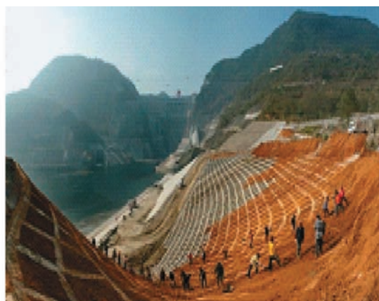
中国农业银行贵州分行支持“西电东送”工程构皮滩水电站
