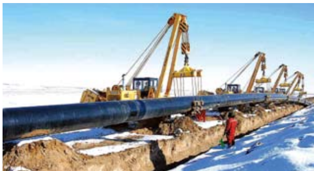
中亚天然气管道建设施工现场
