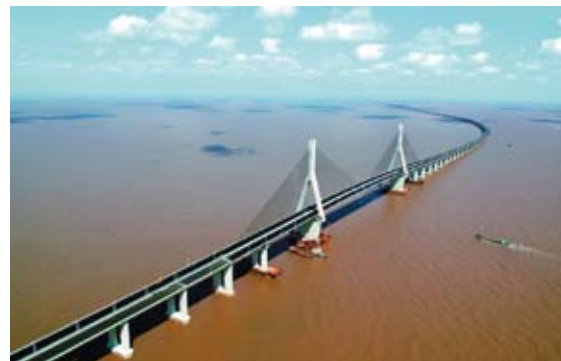
公司承建的东海大桥荣获“2007年度国家科学技术进步奖”一等奖
