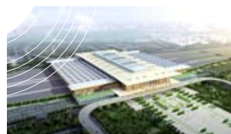
京沪高速铁路南京枢纽南京南站
