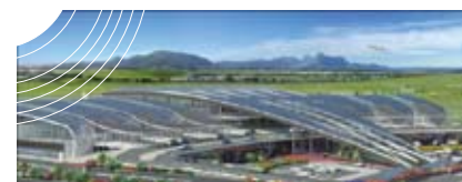
毛里求斯SSR国际机场扩建项目
