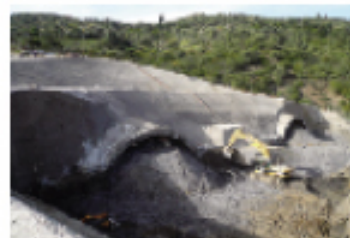
● 阿尔及利亚东西高速公路项目施工现场
