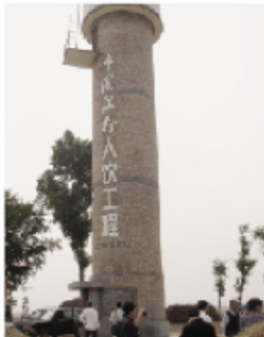
●中行为陕西咸阳地区贫困县修建的饮水工程
