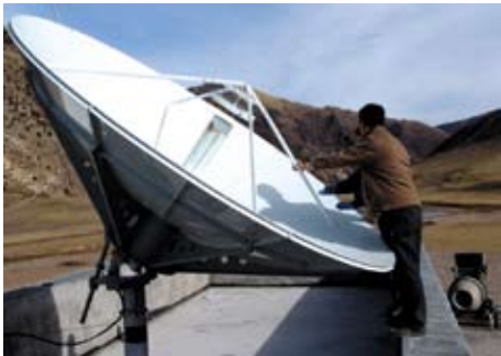
在西藏，“村村通工程”建设者调试卫星设备
