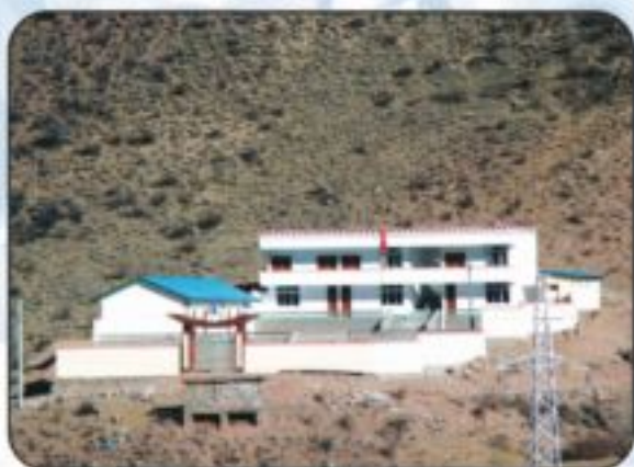
公司在露天上课处建起了教学楼
