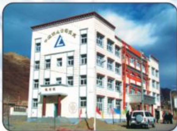
公司在察雅县修建的敬老院
