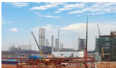
星火20万吨/年有机硅一体化项目（在建）
