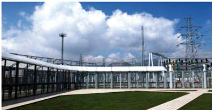
35kV/2kA三相高温超导电缆系统
