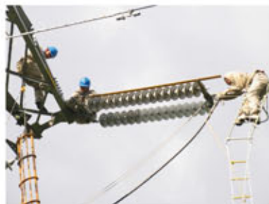
高压线路带电运行工种的现场培训
