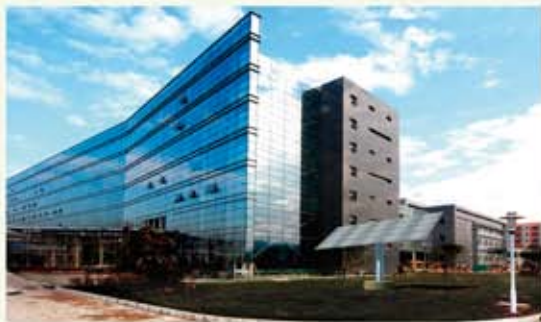
160kWp光伏发电技术集成及并网示范项目
