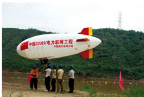
220kV对越南送电飞艇跨越红河
