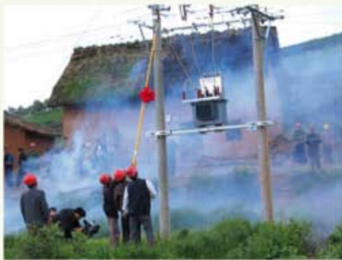
新工程顺利通电
