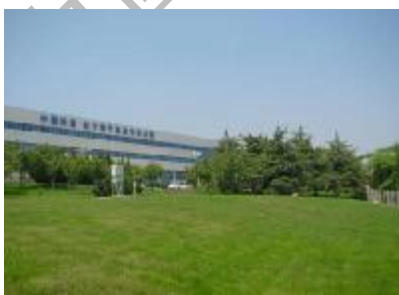
地埋式污水处理装置， 地表绿化覆盖。
