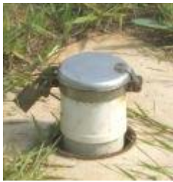
地下水监测井
