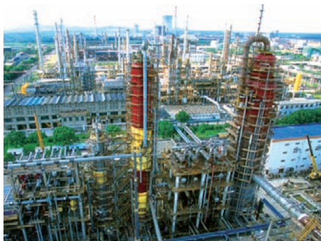
镇海炼化改扩建工程现场
