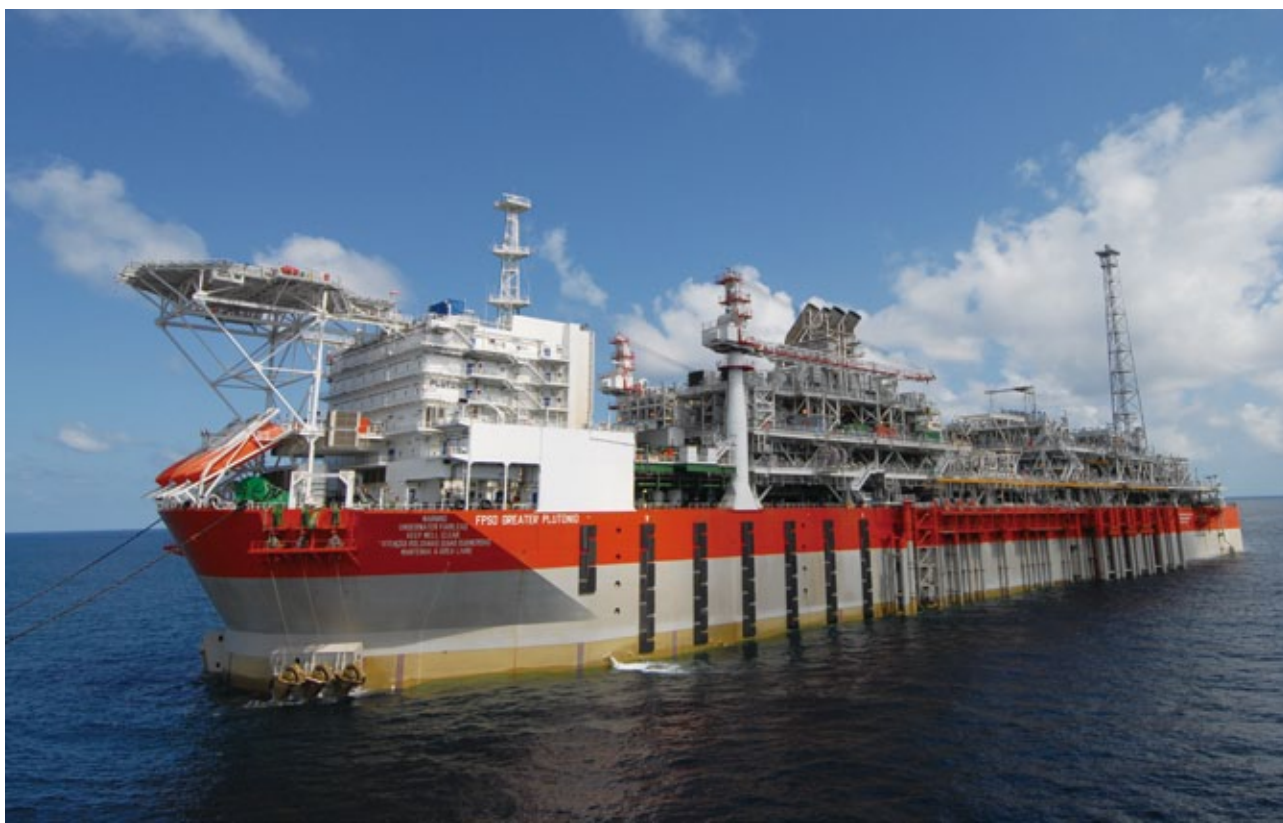
中国石化安哥拉 Greater Plutonio 油田海上作业平台
