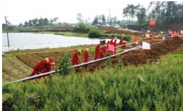
5月，为保证北川的天然气供应，中国石化西南石油局在绵阳安县塔山镇开展灾后重建项目——德阳至新北川的天然气管道工程。
