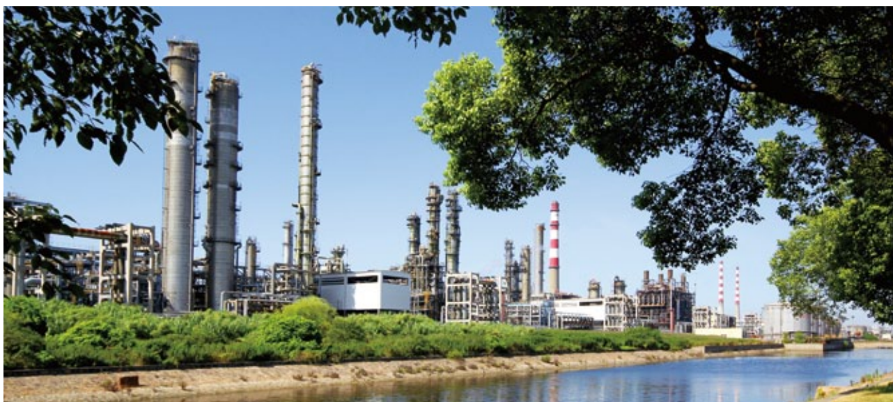
中国石化上海石化
