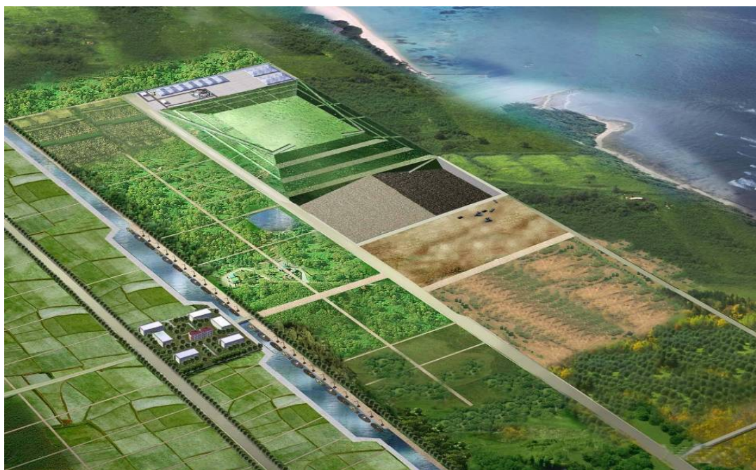
老港生活垃圾卫生填埋场四期工程
