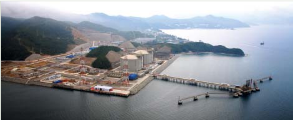
广东大鹏LNG终端场景。
