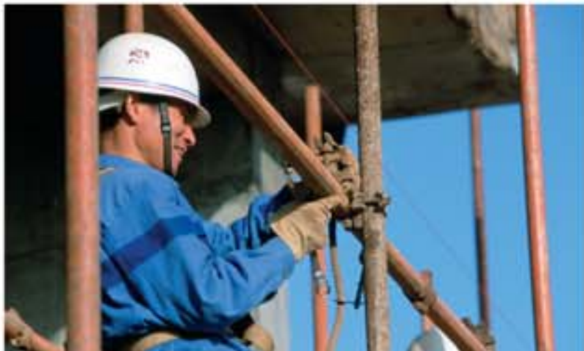
洞庭煤气化项目工地上的建设工人进行高空作业
