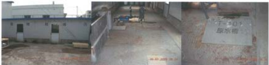
电镀废水储存池
