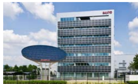
加西绿色能源工业园区。楼宇前是安装了太阳能电池和锂离子电池的太阳能充电站“Solalib”
