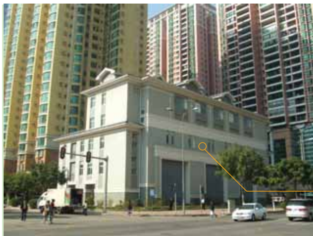
广州市珠江新城110千伏花穗变电站
