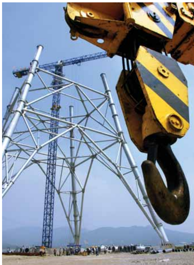
500千伏跨江铁塔建设
