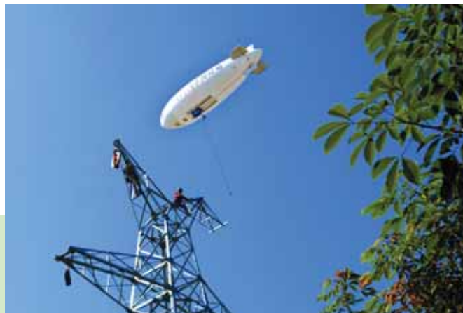
在110千伏云南大渡岗至景洪输电线路建设中，实现国内首次全程采用飞艇放线技术
