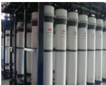
处理量达 200m<sup>3</sup>/h 的超滤装置
