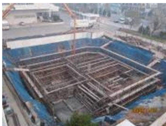
建设中的污水处理设施
