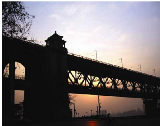
▲ 武汉长江大桥
