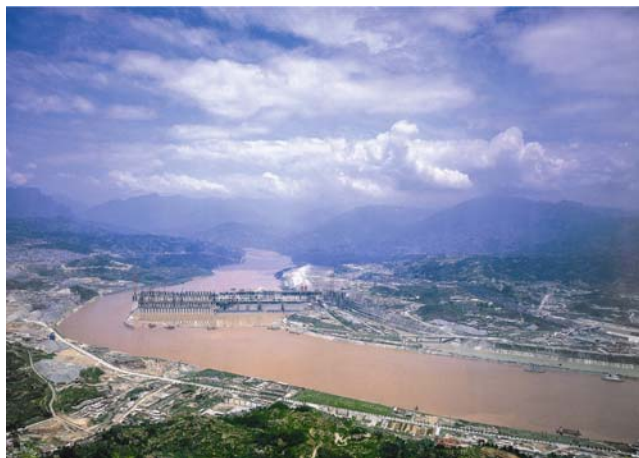
▲ 长江三峡工程
