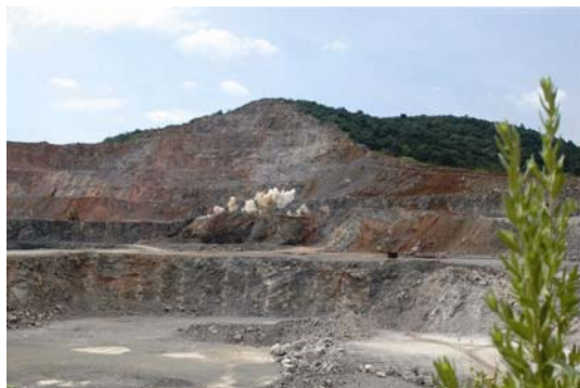
▲ 化新矿山开采实行逐孔微差爆破作业
