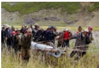
农牧民帮助施工单位抬电杆
