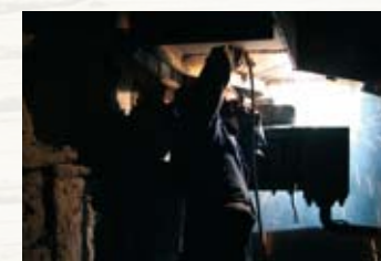
国电内蒙古东胜热电有限公司燃煤器改造
