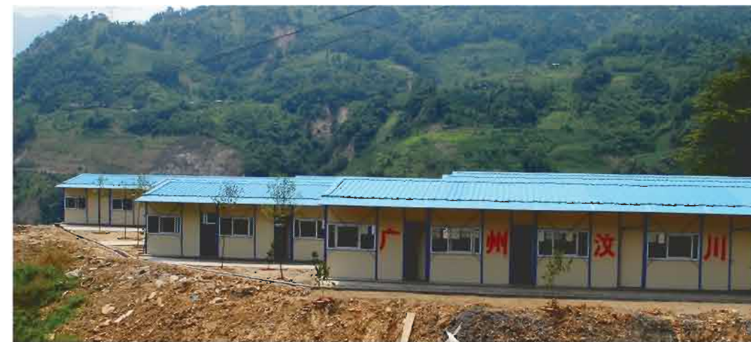
震后之初集团抢建的安置样板房
