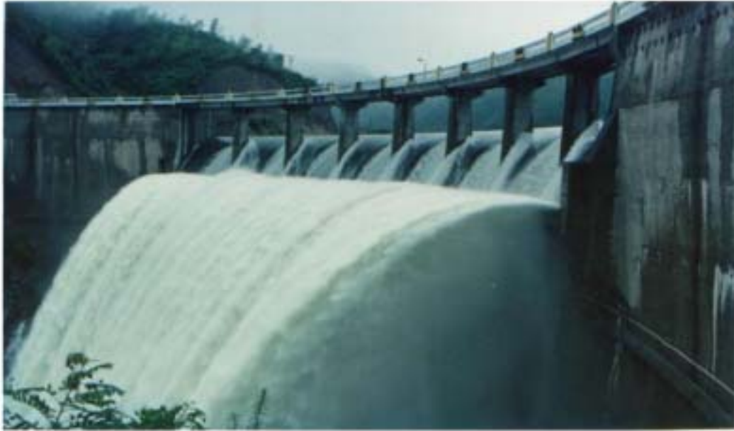
公司主力电站桑园水库电站大坝
