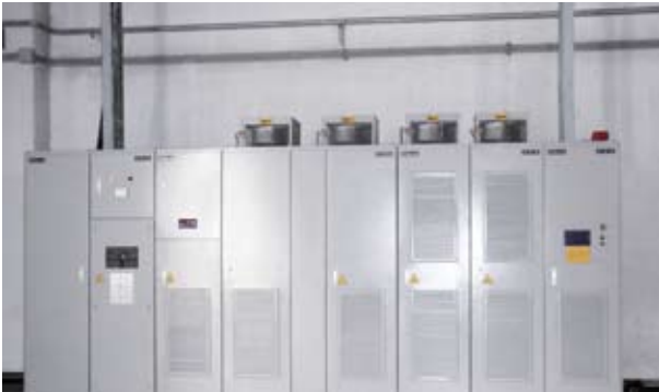
系统企业将变频技术广泛用于凝结水泵、热网疏水泵、燃油供应泵等设备。
