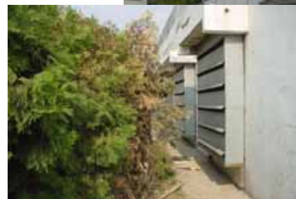
空压机室窗户上安装的降噪装置
