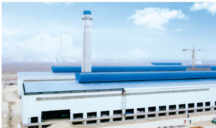
○ 建设中的内蒙古再生资源公司
