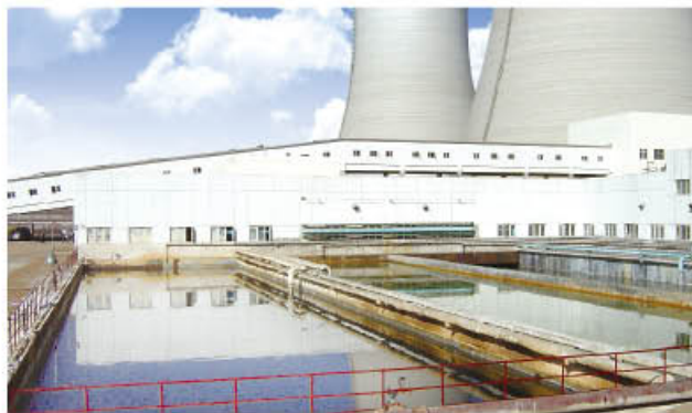
○ 山西神头发电公司污水处理站
