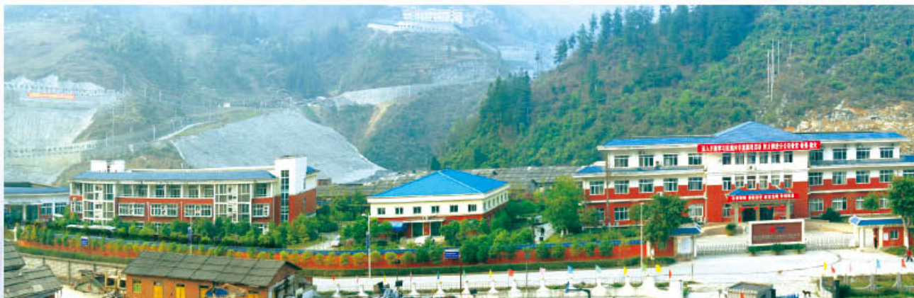
○ 重庆彭水水电公司生活营地
