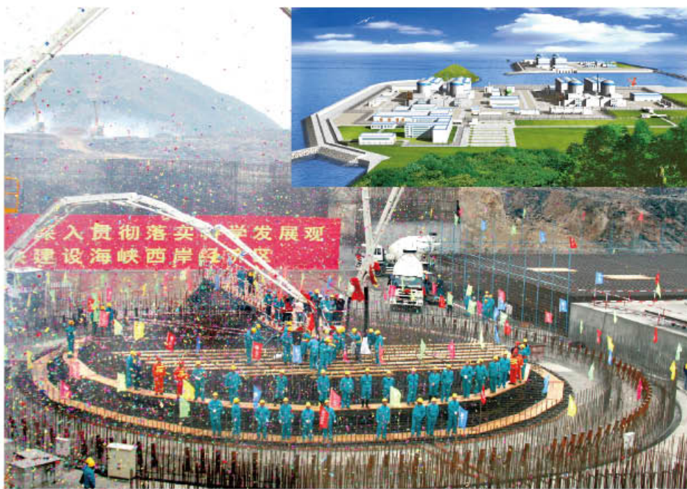
○ 建设中的福建宁德核电
