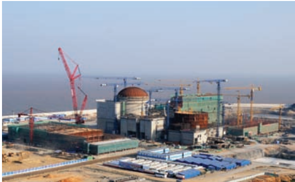
○ 建设中的福建宁德核电
