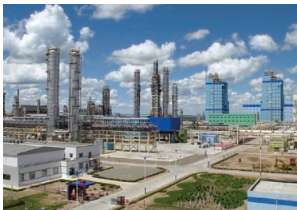
○ 内蒙古多伦煤化工项目
