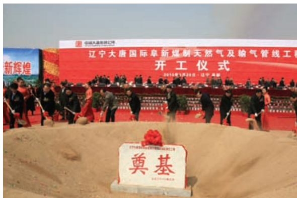
○ 辽宁阜新煤制天然气项目
