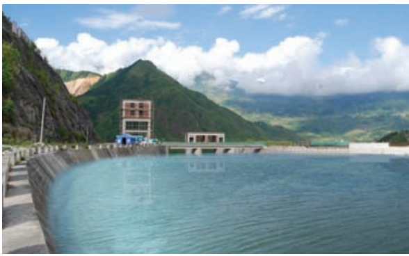
○ 云南马鹿塘水电站成功下闸蓄水
