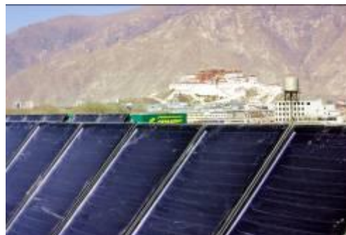
博世热力技术为中国电信集团西藏公司应急指挥中心安装了太阳能集热器
