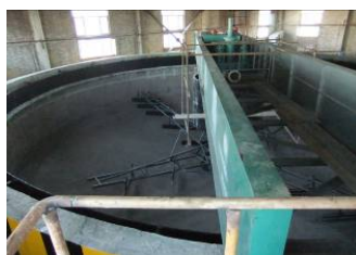
稀选厂三车间改造后的 18 米大井
