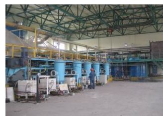
冶炼厂一车间改造后的错钕碳沉生产线
