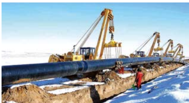
中亚天然气管道建设施工现场
