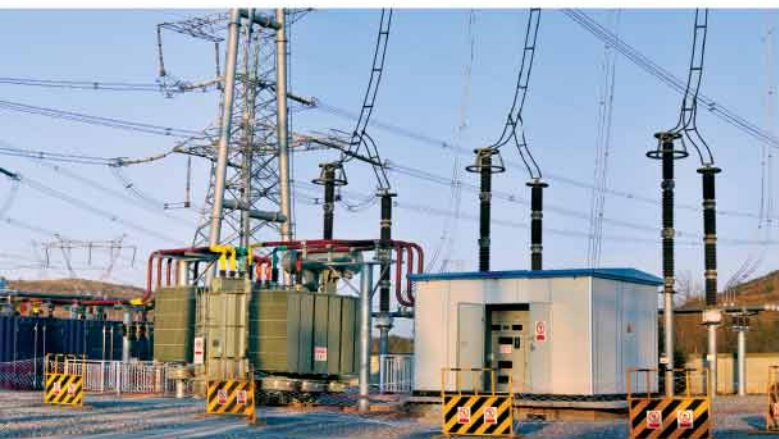
自主研发的直流融冰设备投入运行
