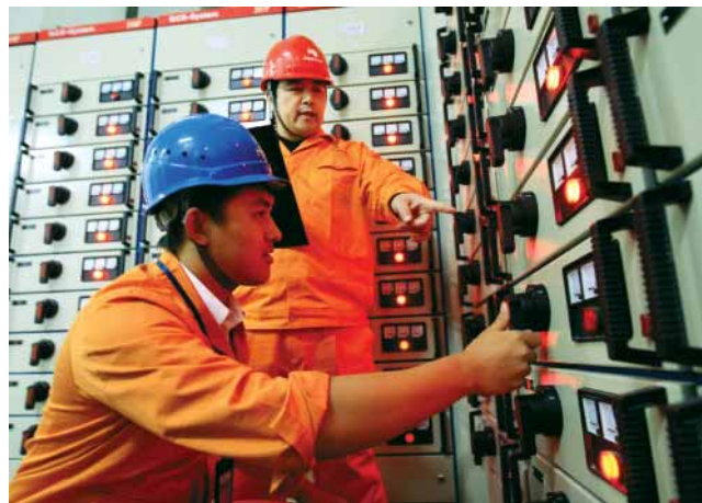
为避免客户停电，运行人员正在转供电
