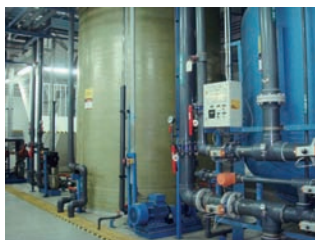
在纯水系统中回用反冲洗水
