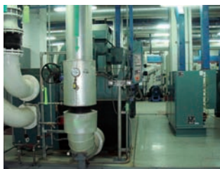
加装变速控制器的冷冻机
