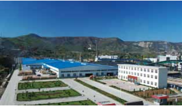
南煤集团煤研石烧结砖二期工程建成投产，形成 2.3 亿块研石砖生产能力，每年可消化煤研石约 28 万吨。
