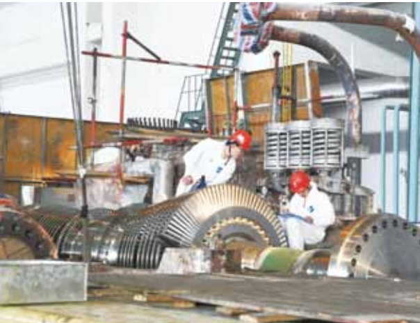
华夏电力2号机组汽轮机通流改造现场
