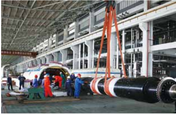
靖远二电 5 号机组汽轮机通流部分和真空系统改造现场
