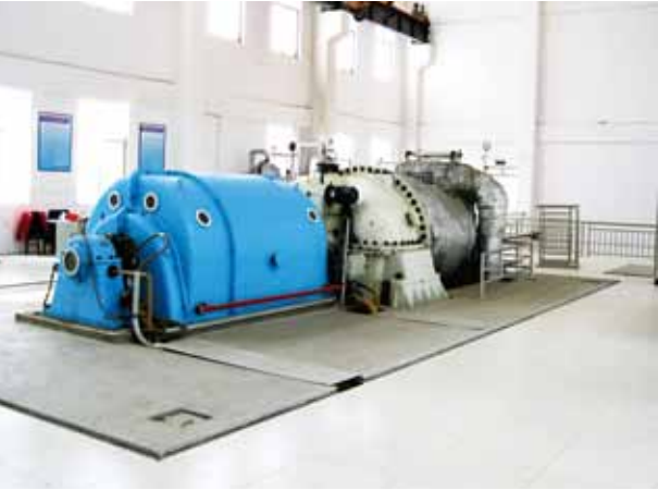
云南滇东水泥窑低温烟气余热电厂汽轮发电机
