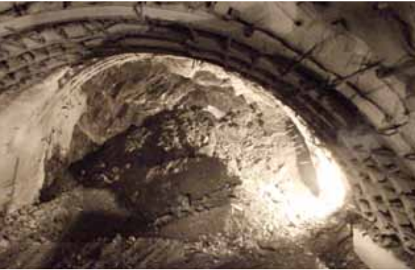
二滩水电锦屏二级水电站4号引水隧洞全线贯通
