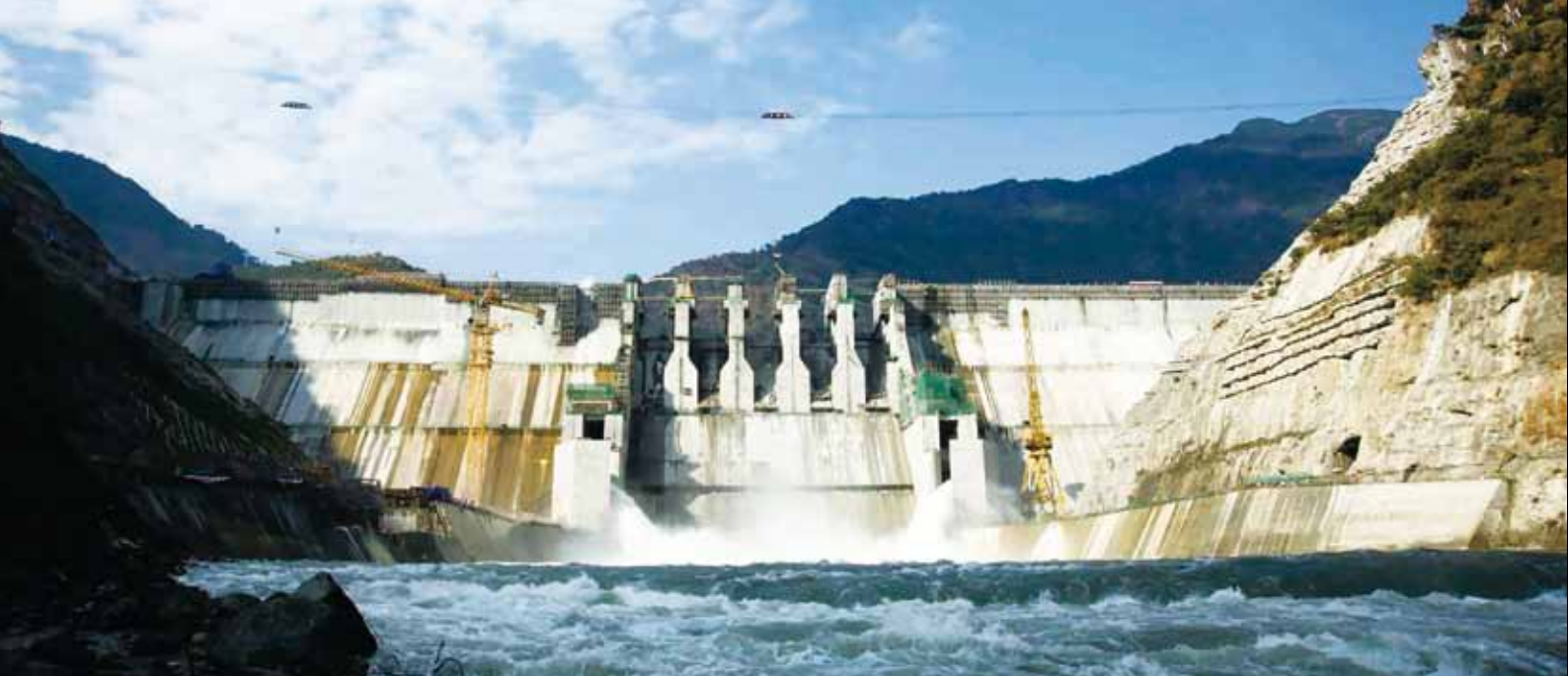
二滩水电官地水电站碾压混凝土大坝
