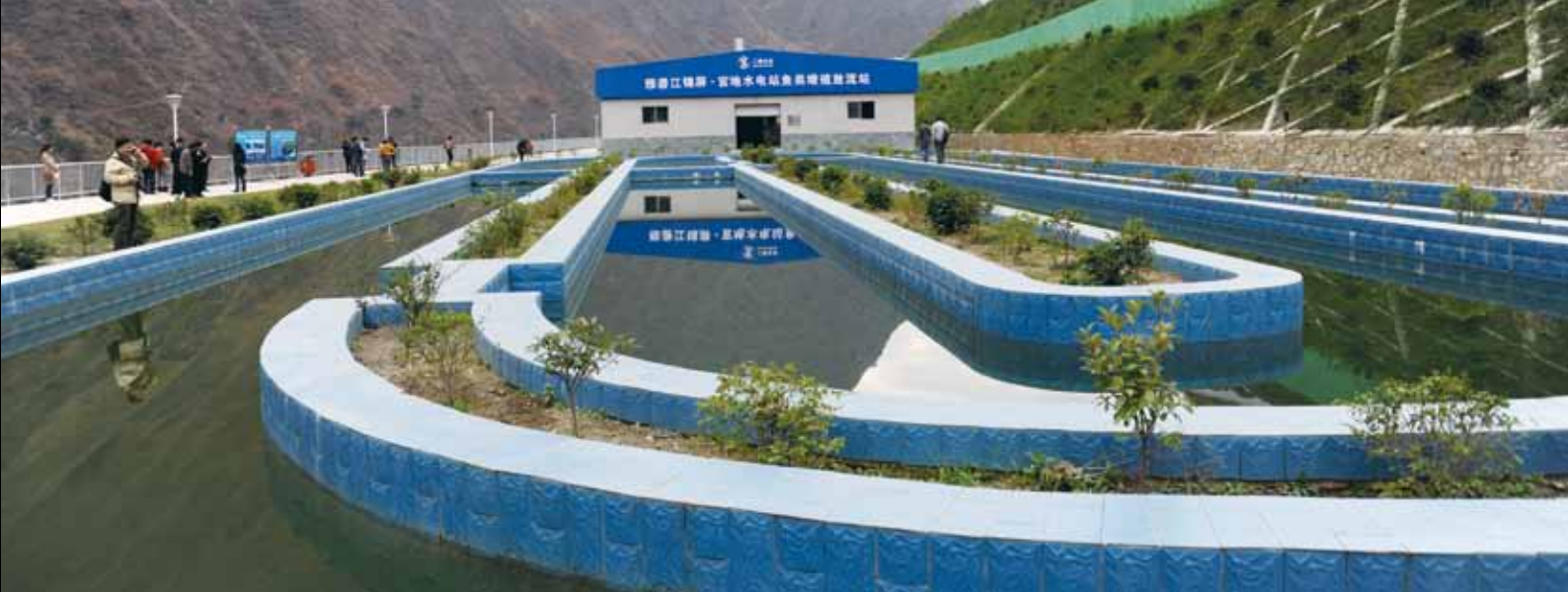
二滩水电官地水电站鱼类增殖放流站
