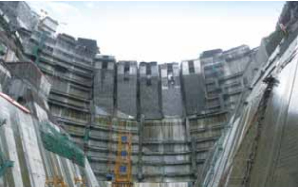
二滩水电锦屏一级水电站大坝建设现场
