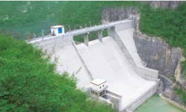
国投晋城围滩水电站全景
