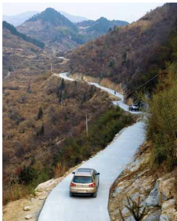
中国石化在扶贫县修建的公路
