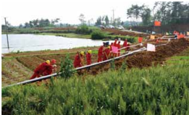
5月，为保证北川的天然气供应，中国石化西南石油局在绵阳安县塔水镇开展灾后重建项目——德阳至新北川的天然气管道工程。
