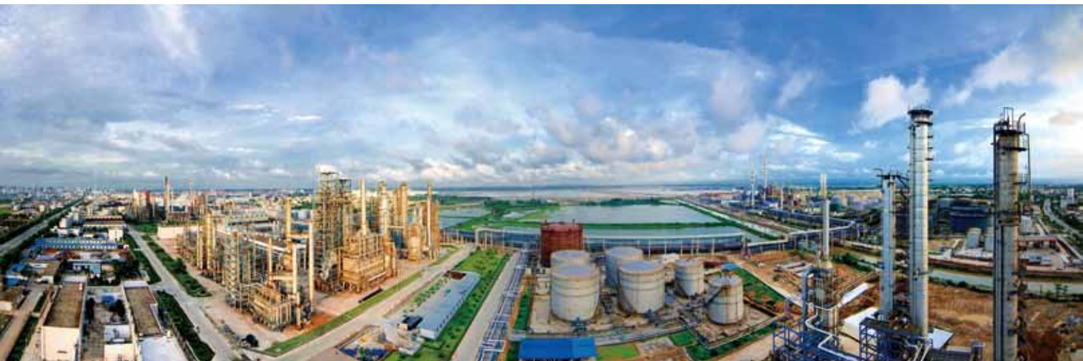
中国石化湛江东兴石油化工有限公司全景
