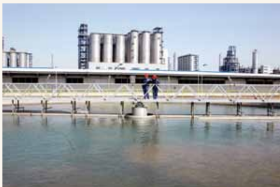
中国石化天津乙烯厂区
