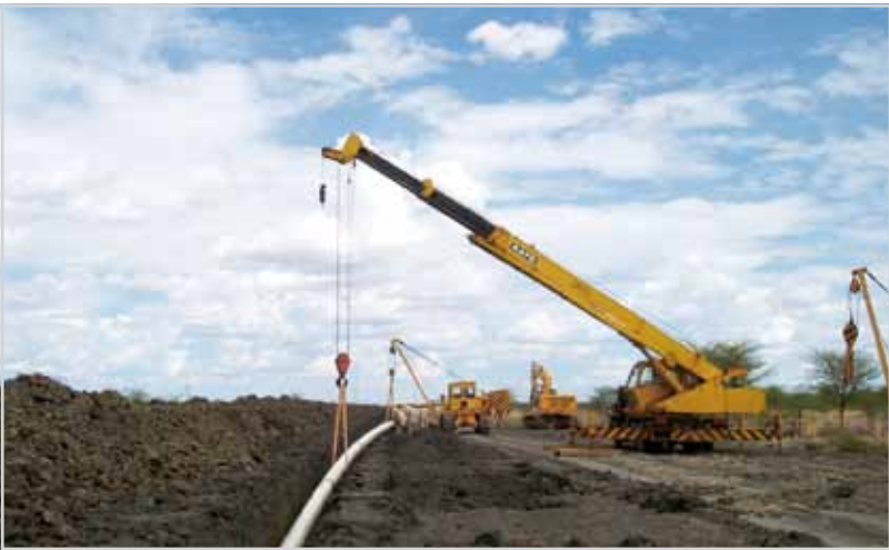
苏丹1/2/4区原油外输管道建设现场
