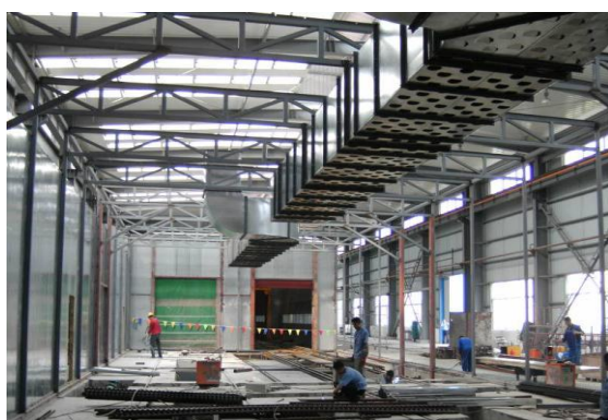
改造中的太仓水性涂装线
